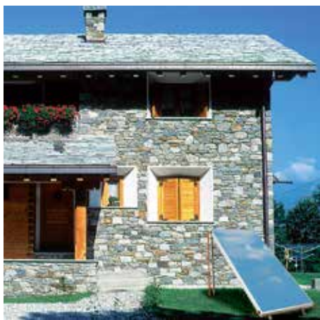
Пример наземного монтажа
